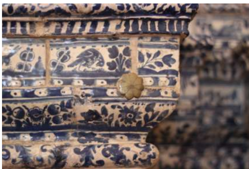
Рис. 50. Деталь крепления изразцов на «голландской» печи в Крестовой палате Суздаля. Рубеж XVII-XVIII вв.
